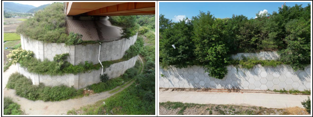
【사진 12.3.2】 전면부 전경
