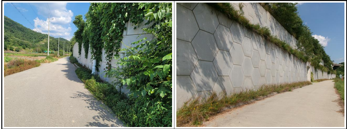
【사진 12.3.1】 지반, 기초부 전경
