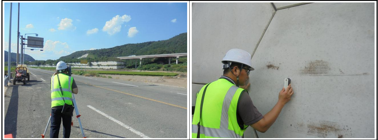
【사진 12.4.2】 측량작업 전경
